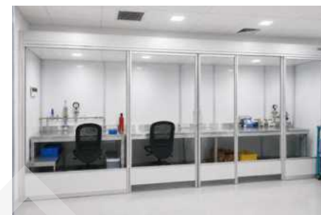
クリーンルーム組立室 Clean Assembly Room
